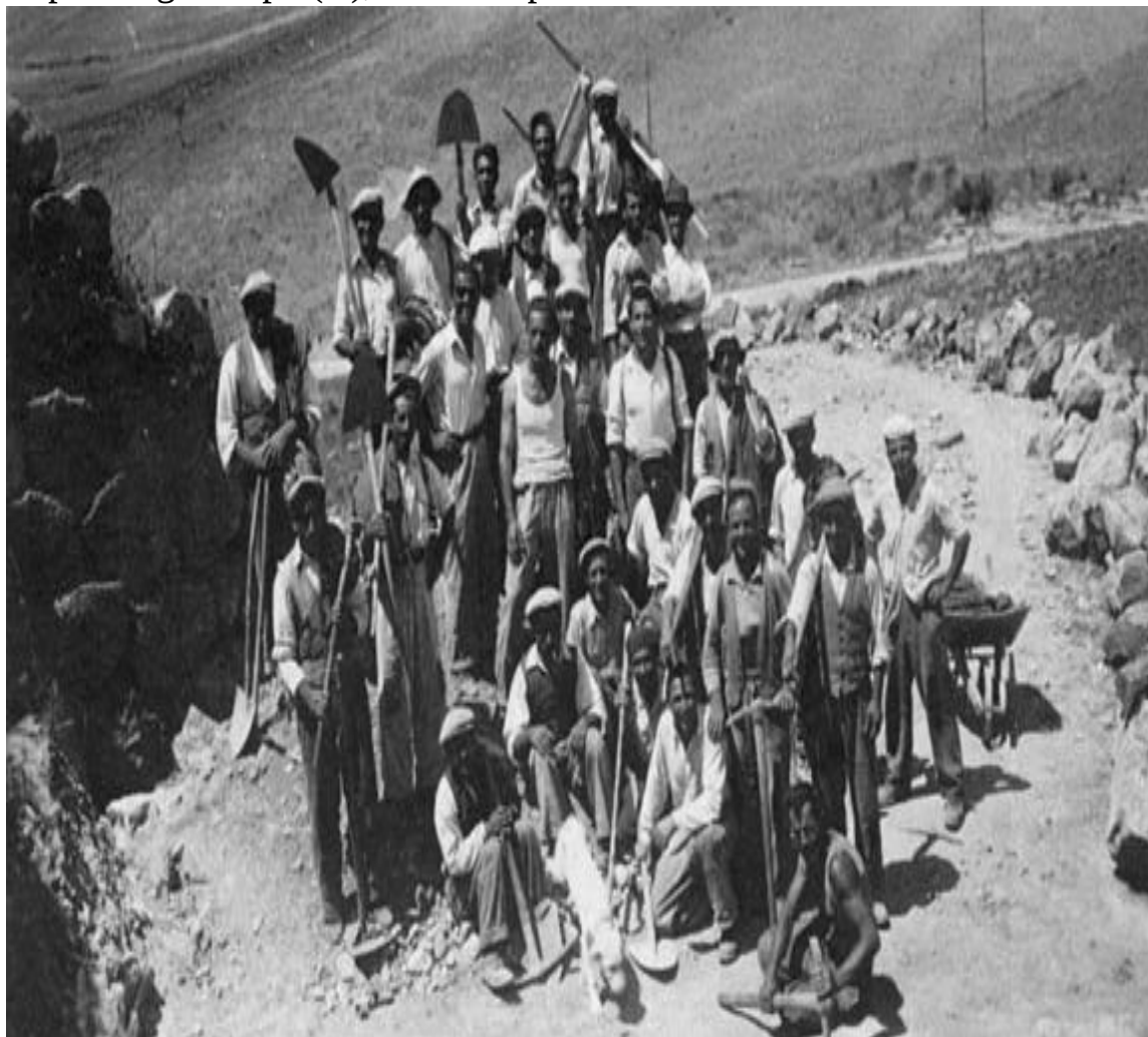
Fig. 17 Barumini, Su Nuraxi. Operai alla fine di un cantiere di scavo.
