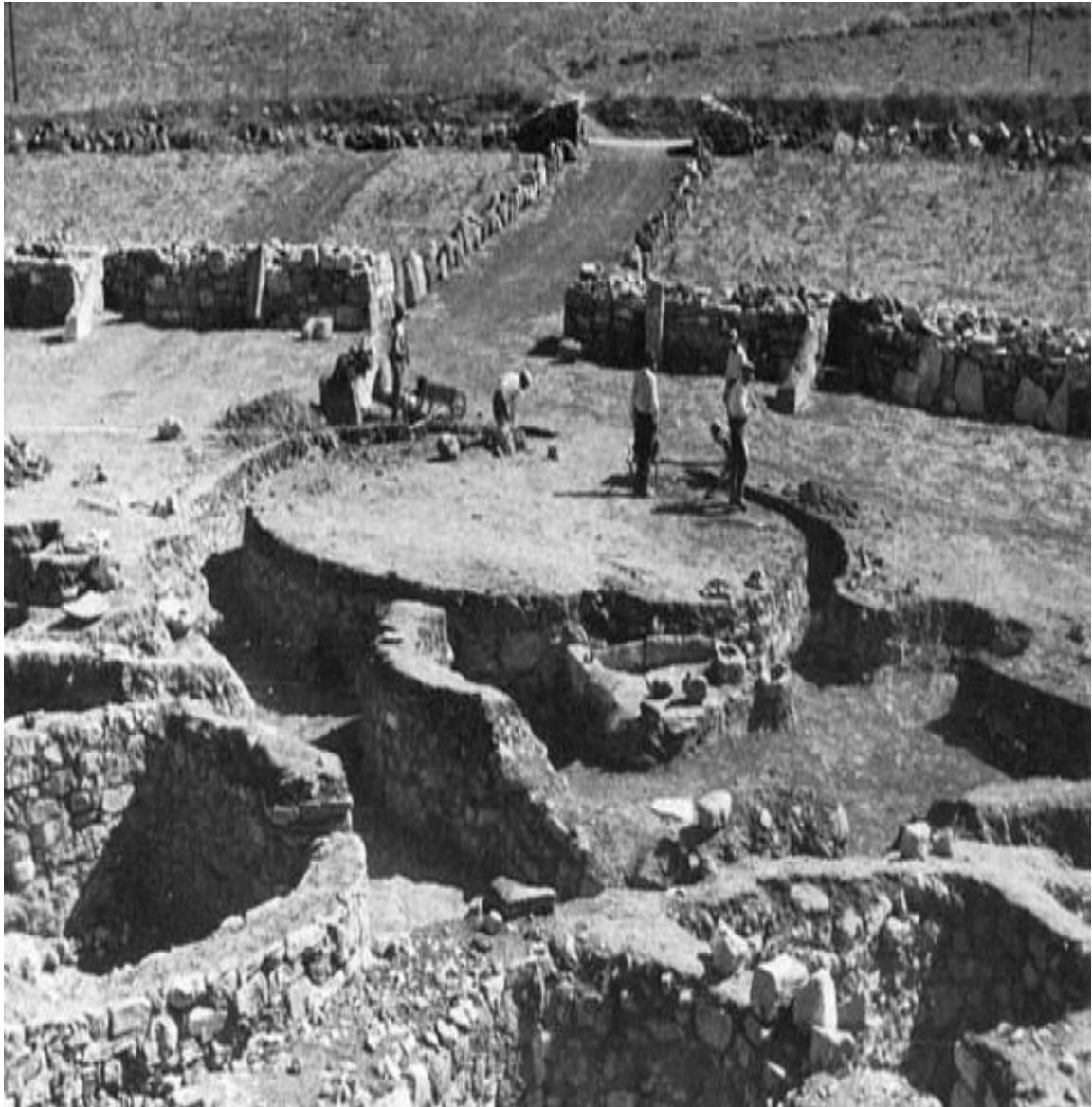
Fig. 16 Barumini, Su Nuraxi. Preparazione di scavo della Sala delle riunioni (vano 80).
