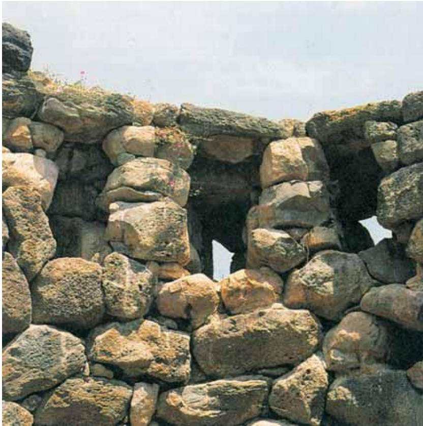
Fig. 51 Barumini, Su Nuraxi. Torre M dell'antemurale:feritoie dell'ordine superiore del vano.
