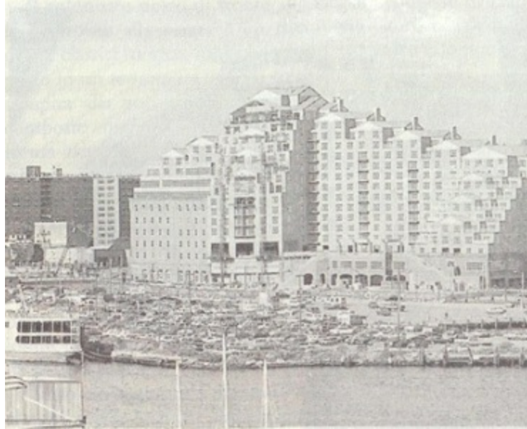
Figura 4.17 Scarlett Place di Baltimora riunisce la conservazione storica (lo Scarlett Seed Warehouse del XIX secolo incorporato nell'angolo a sinistra) e la voglia postmodernista di citazioni, in questo caso di un villaggio di collina mediterraneo (notate l'edificio di edilizia popolare modernista sullo sfondo).
