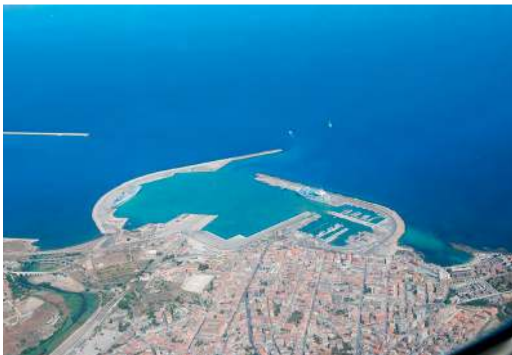
Porto Torres, la città. Nel settore ovest l'area dell'istituendo Parco.
